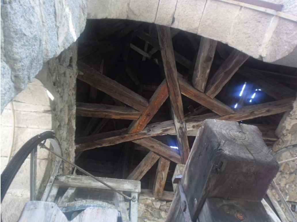
Sistema a capriate della struttura portante del tetto
