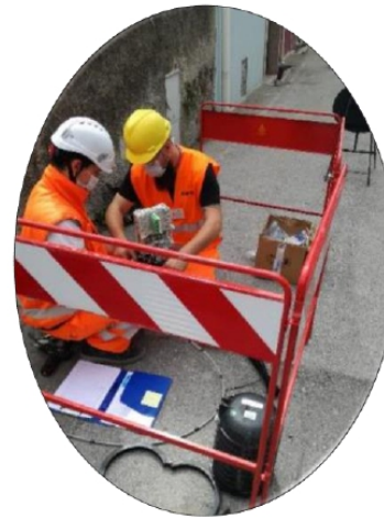
I nostri tecnici mentre giuntano il cavo in fibra ottica per portarlo in casa
