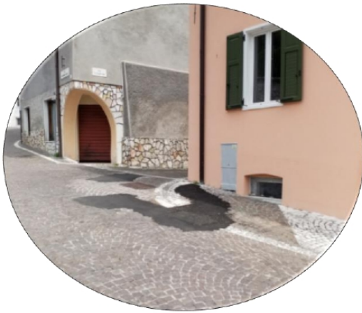
Collegamento a pozzetti rete elettrica per riutilizzo tubazioni che entrano in casa
