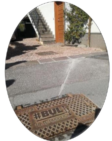
Esempio di scavo su proprietà pubblica e collegamento ad infrastruttura del privato
