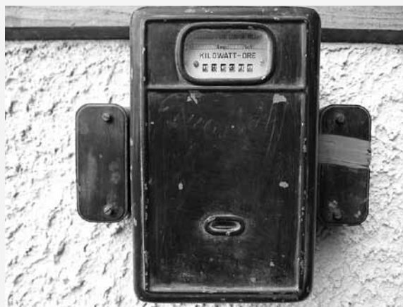
Contatore marca Sisy Chamon, Milano, adottato dall'Azienda elettrica a fine anni '40 – per linea a 220V (Foto autore – propr. Comune Ossana)
